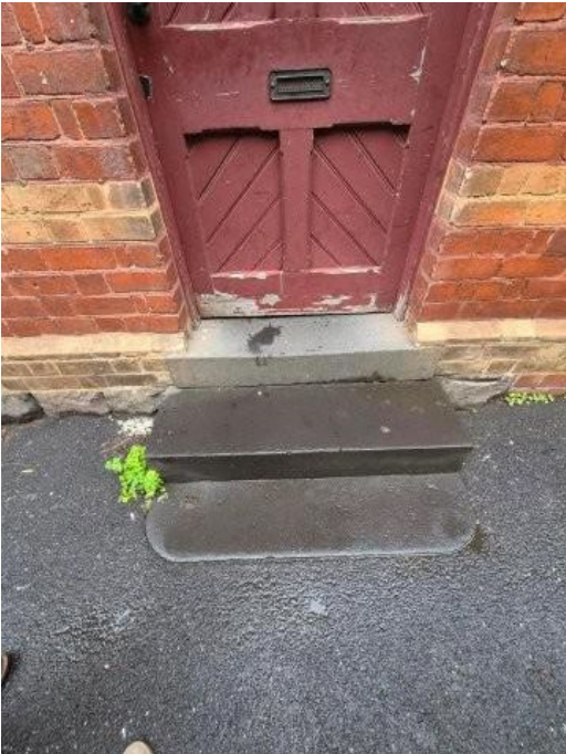
STONE SILL & STEPS BENEATH EXISTING DOOR
