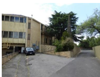
St Justin's retaining walls (D)
